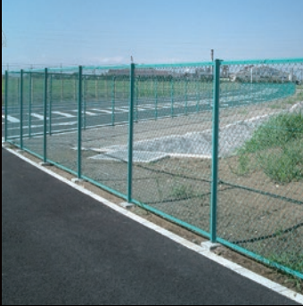
ネットフェンス
